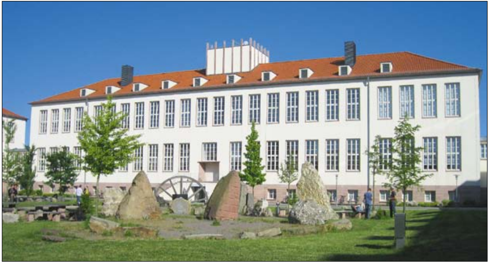
Abb. 1 Das Institutsgebäude der Geographie auf dem Heide-Campus der Martin-Luther-Universität (Foto: KNABE 2009)
