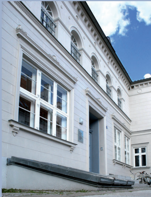
Abb. 12 Haus „Alte Apotheke“ nach denkmalgerechter Sanierung (© Alfried Krupp Wissenschaftskolleg Greifswald, Fotograf: Vincent LEIFER)
