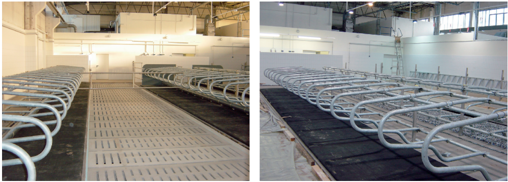
Abb. 5 Der BSE-Sicherheitsstall: Freilaufstall mit Freßplätzen, Liegeplätzen mit Gummimatten und Spaltenboden.
