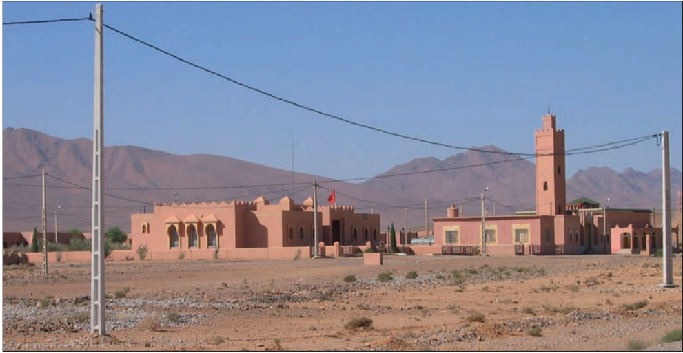
Abb. 3 Neu angelegtes Gemeindezentrum auf den ostmarokkanischen Hochplateaus mit Moschee, Verwaltungsbauten und Krankenstation. Neue Siedlungen entwickeln sich entlang staatlich angelegter Infrastruktur. Foto: Ingo BREUER
