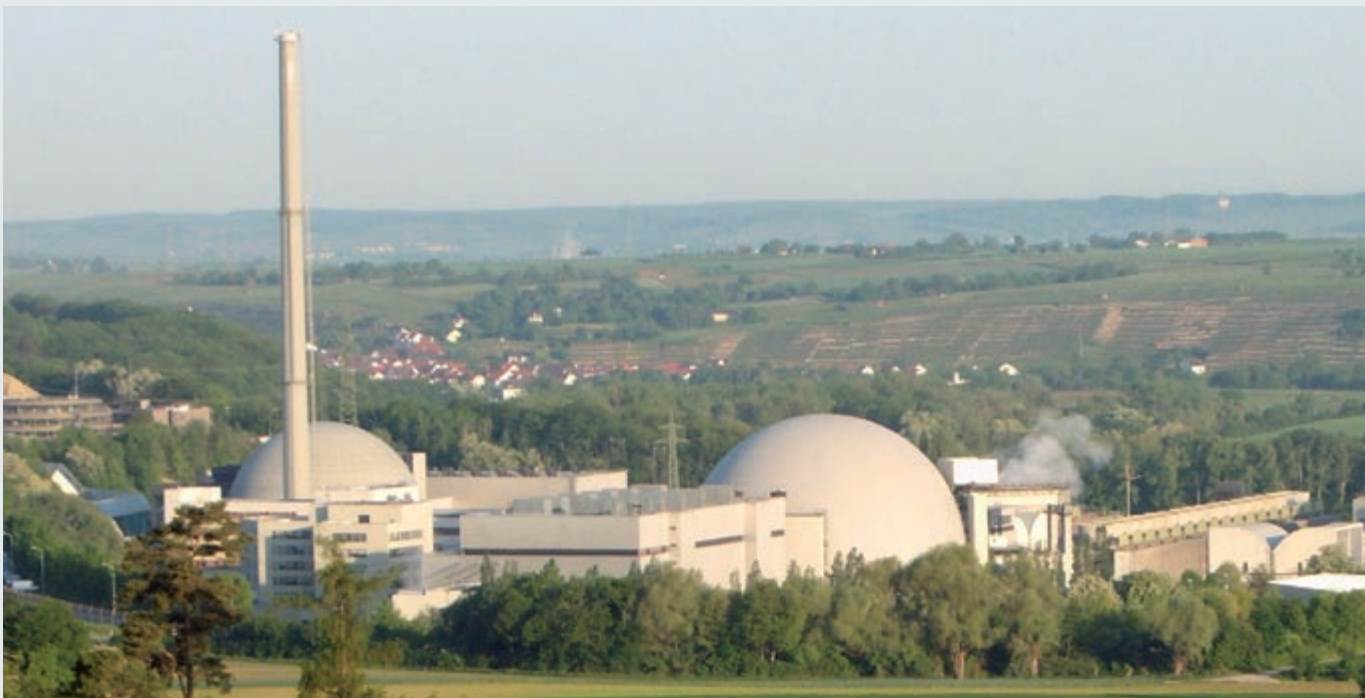
Kernkraftwerk Gemeinschaftskraftwerk Neckar (GKN) bei Neckarwestheim, aufgenommen vom Burgfried des Schloss Liebenstein. In der Bildmitte die Zellenkühler von Block 1, Rechts der Hybridkühlturm von Block 2. (Quelle: FZK)
